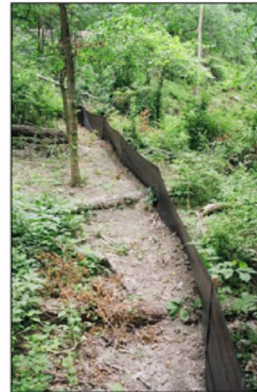
TYPICAL SILT FENCE INSTALLATION
