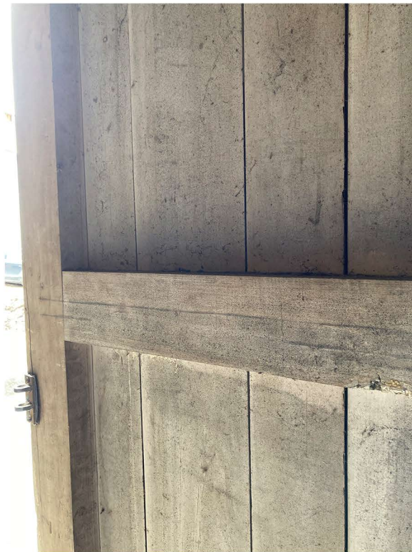
NEW BARN DOOR FRAMING
