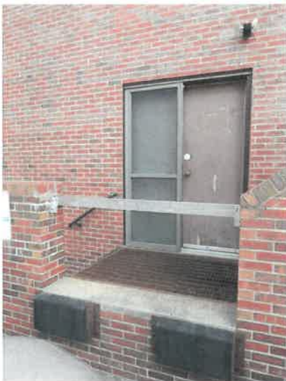
Existing Exterior Door
