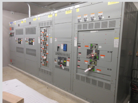
SWITCHGEAR
